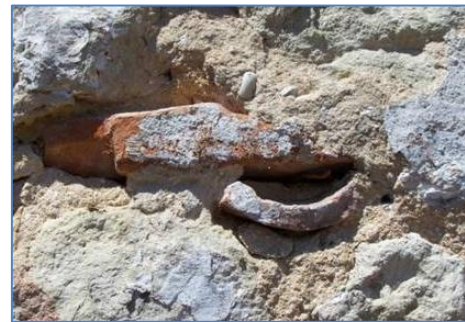
Afb. 31. Romeins bouw materiaal in de muur van de kerk van Merkelbeek. Duidelijk herkenbaar zijn de Romeinse dakpannen, maar ook onder de kalkstenen kan zich Romeins afbraakmateriaal bevinden.
