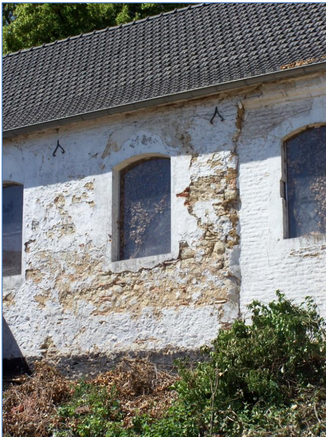
Afb. 30. Zuidmuur van de kerk van Merkelbeek.
